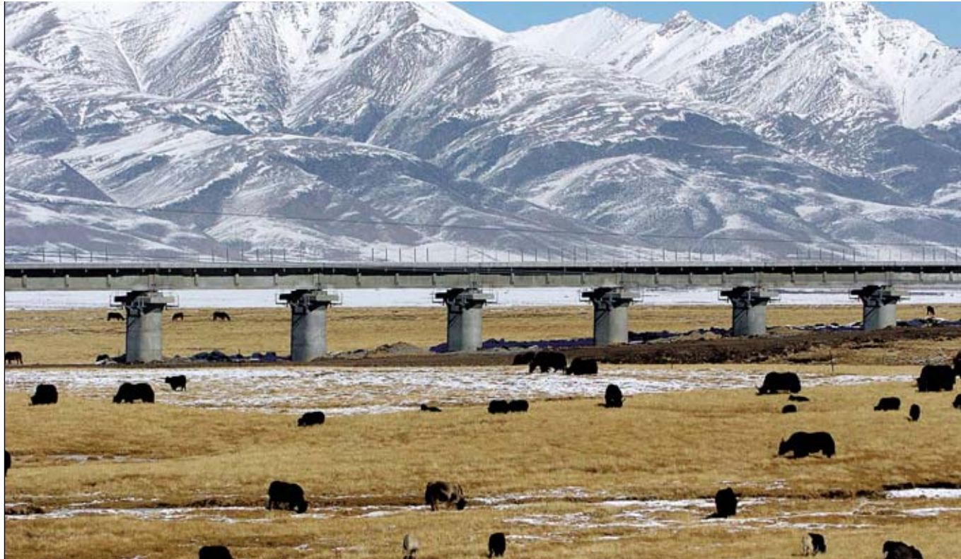
Una estructura sobre pilares sostiene parte de la vía para que ésta no esté asentada sobre terreno congelado. Debajo, un túnel de la línea.
